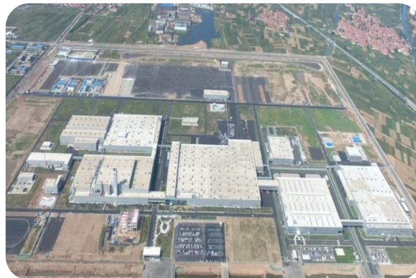
沧州工厂正式竣工
